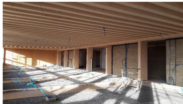
Ecole de Marly en construction avec du bois local
