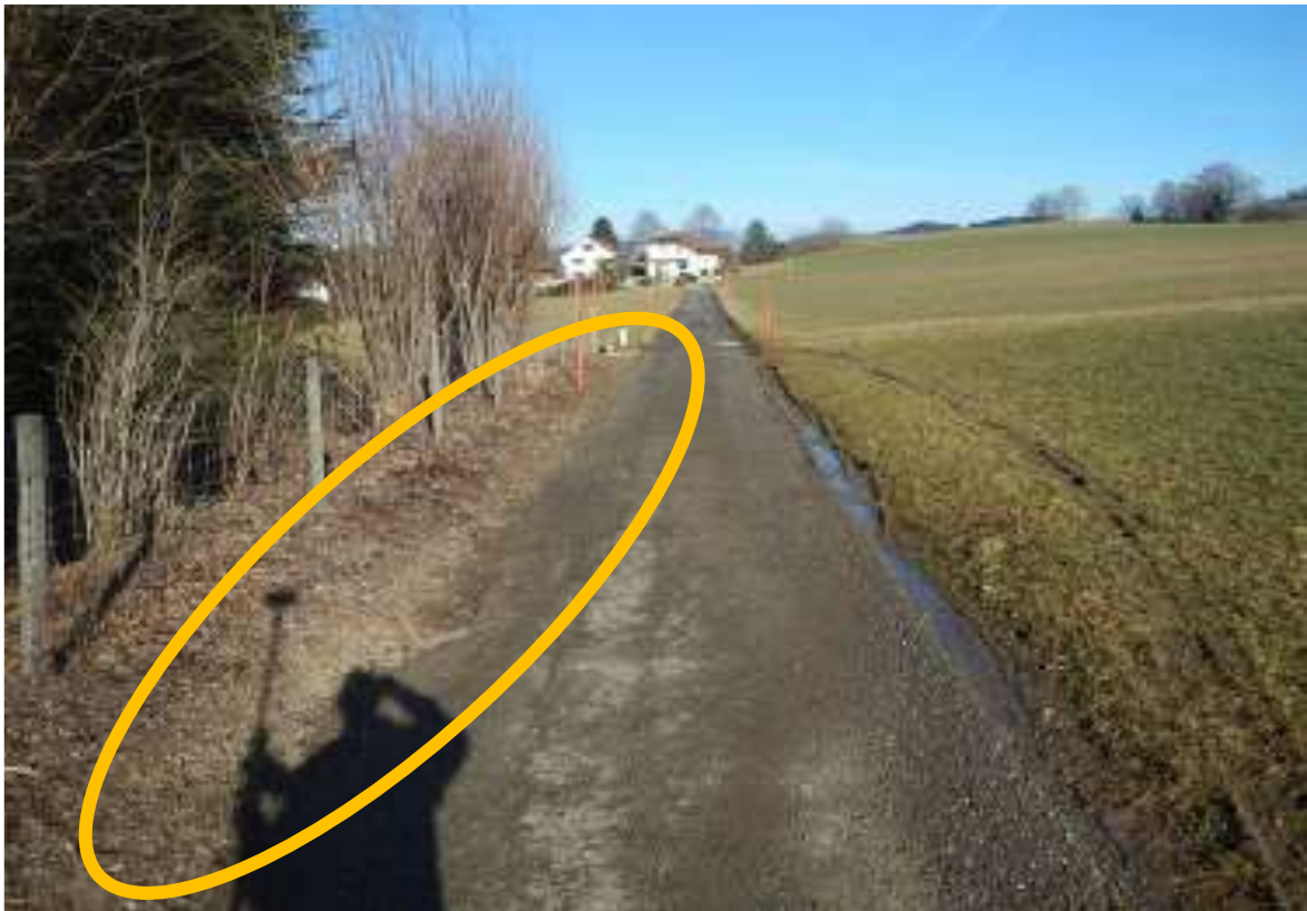
Figure 3 : Le Chemine des Biches avant les travaux, dans le secteur où ont eu lieu les inondations ; l'affaissement de l'ancienne route a créé une rétention d'eau, c'est pourquoi les réclamations pour inondations avaient diminué au fil des ans : plus la route était abîmée, moins il y avait d'inondations.
